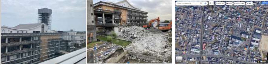
解体工事が始まった旧羽島市庁舎
