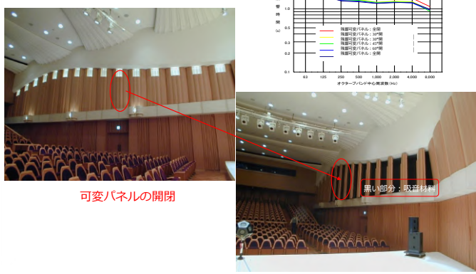
残響可変装置 (トッパンホール)
