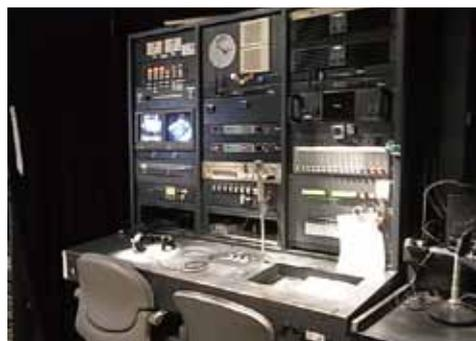
(左上から)大ホール舞台、舞台下手(客席から向かって左側)の袖中2階部分にある舞台機構の操作車。下手袖の舞台監督用の操作盤。
