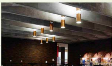
常設展示室 天井とライト ジョイントスラブ天井
