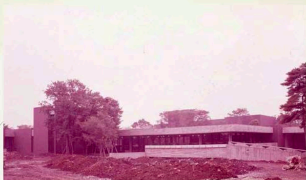
建設中の埼玉県立博物館
