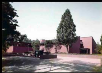
アプローチ外観
