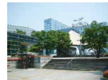
3月31日をもって閉館する熊谷会館
